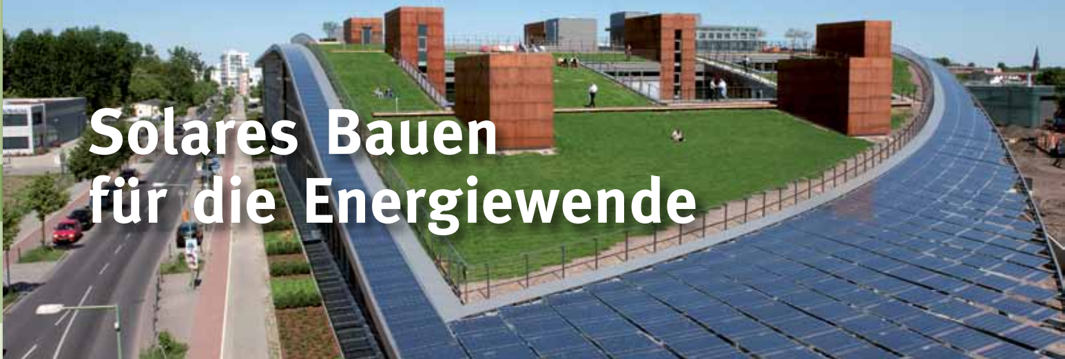
Corporate Headquarter der SOLON SE in Berlin, Verwaltung und Produktion, mit gebäudeintegrierten PV-Modulen und begehbaren Dachlandschaft. SFA/Schulte-Frohlinde-Architekten, Berlin. Nur wenige Hersteller von Solarmodulen engagieren sich in der Weiterentwicklung der Produkte für den GIPV-Markt (gebäudeintegrierte Photovoltaik).
