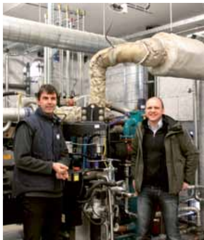
Detlef Heß und naturstrom -Projektentwickler Christof Thoss vor dem BHKW, 265 kW el , elektrischer Wirkungsgrad 46%
