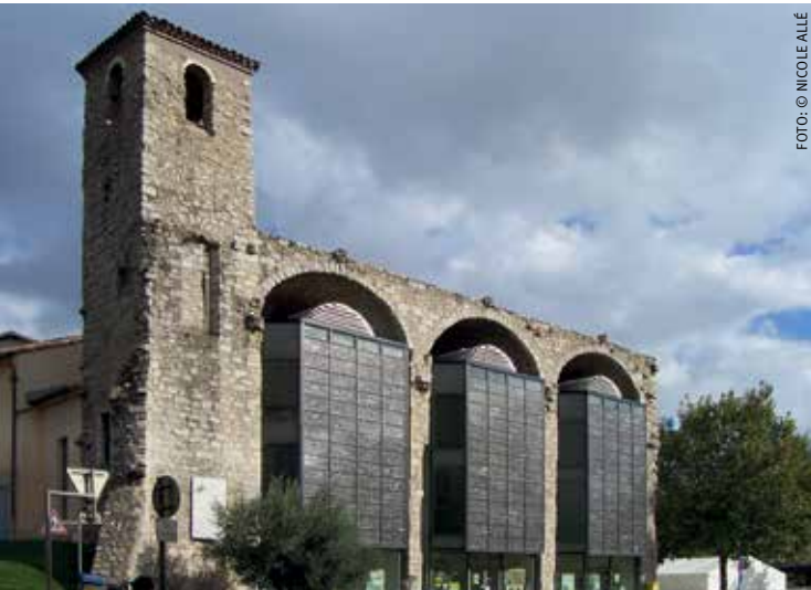
Solarfassade an einer denkmalgeschützten Kirche in Alès/Südfrankreich
