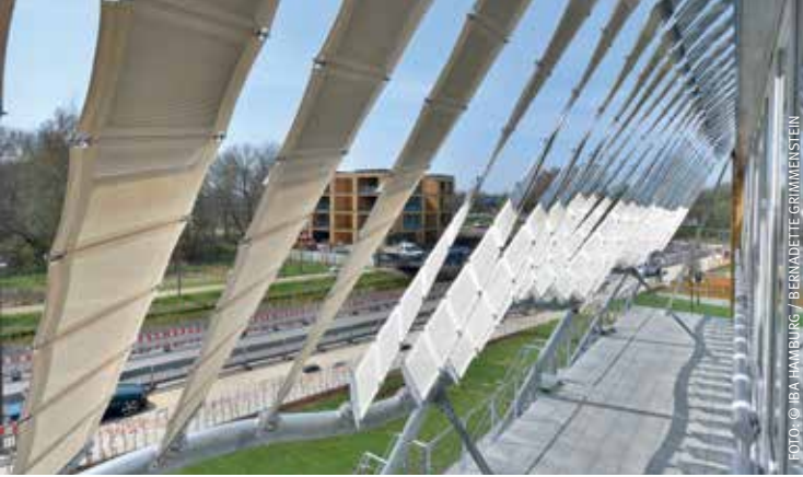
Soft House IBA Hamburg: Textile Membranfassade mit integrierten PV-Modulen
