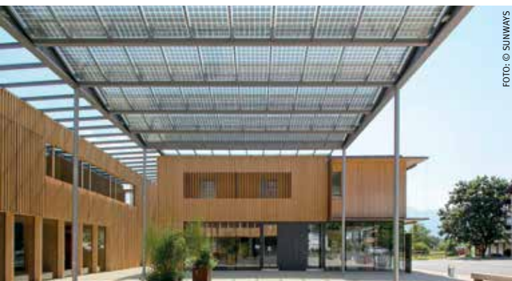
Gemeindezentrum Ludesch mit Überdachung aus transluzenten PV-Elementen
