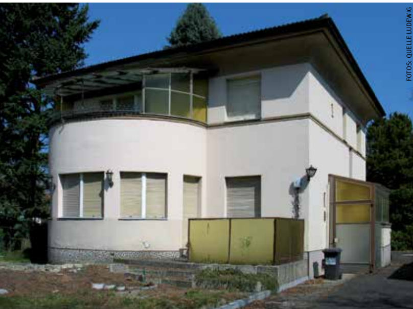
Rodensteinstraße Berlin vor der Sanierung
