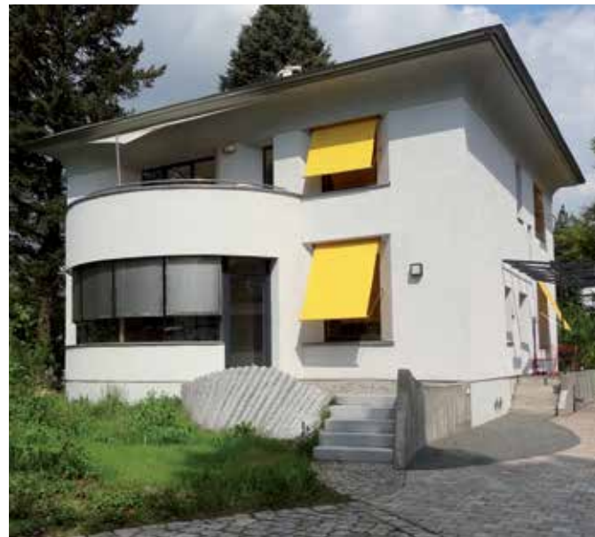
Rodensteinstraße Berlin nach der Sanierung
