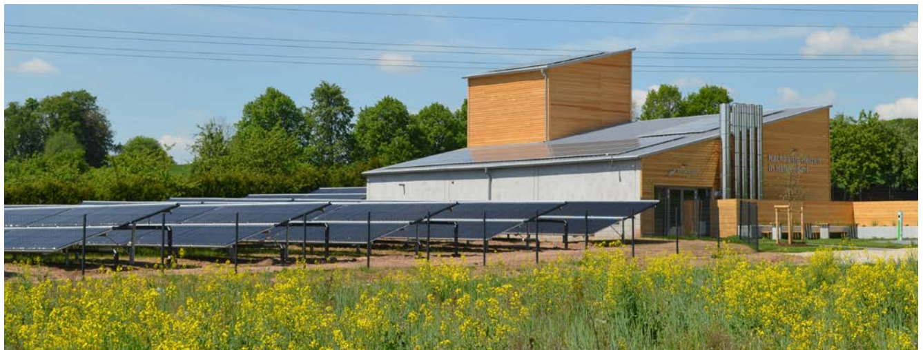
Hallerndorf: 2018 erfolgt der dritte Bauabschnitt im ausgezeichneten Nahwärmeprojekt
