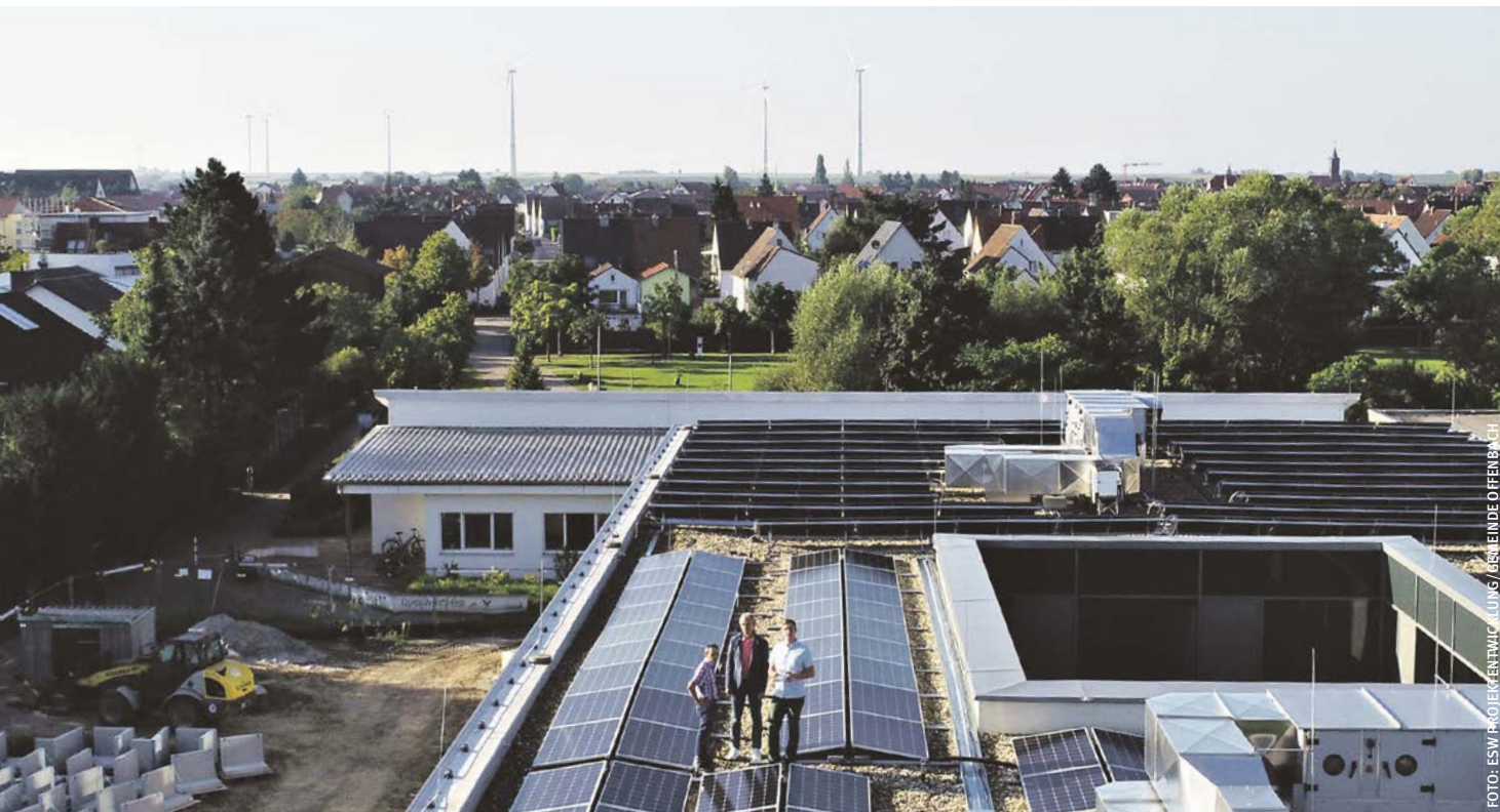
Auf dem Dach des neuen Rathauses erzeugen Kombimodule Strom und Wärme
