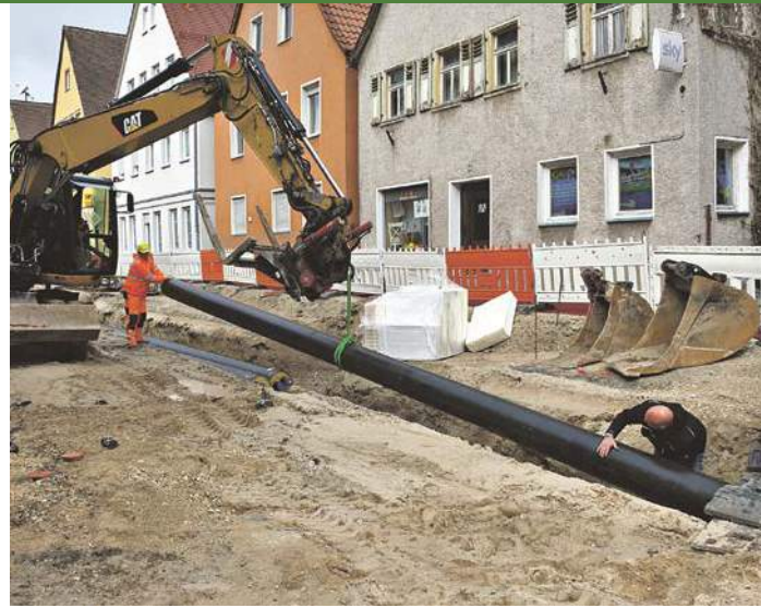
Durch diese Rohre fließt bald neue Wärme
