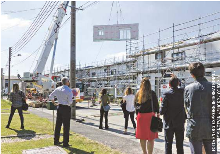
Im französischen Longueau wird die Energiesprong-Fassade installiert
