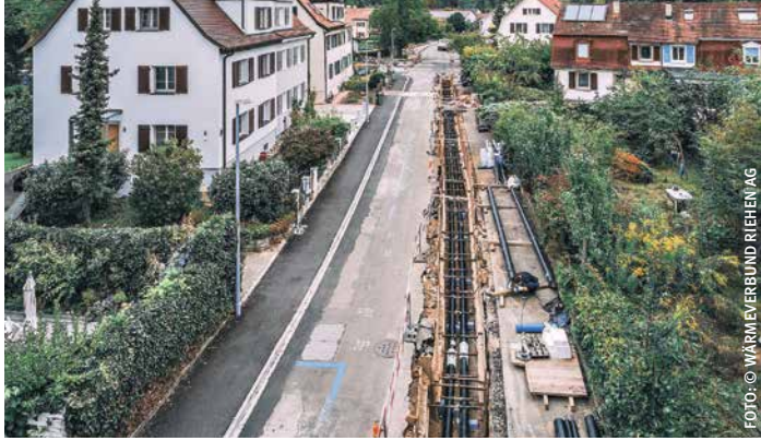
Verlegung eines Wärmenetzes in einem Wohngebiet im Süden Lörrachs: Eine riesige infrastrukturelle Herausforderung
