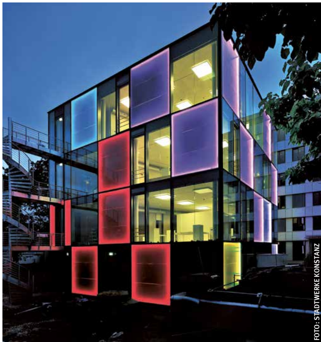
Im solaren Energiewürfel, dem Kundenzentrum der Stadtwerke Konstanz, finden Bürger Beratung zu allen Themen rund um Energieeffizienz und Klimaschutz
