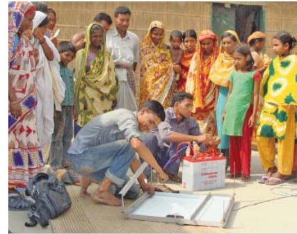
Der einfache Aufbau eines kleinen Solarpanels mit einer Akku-Batterie...
