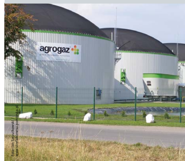
Polens größte Biogasanlage in Liszkowo: Die Anlage schafft eine Leistung von 2,126 MW
