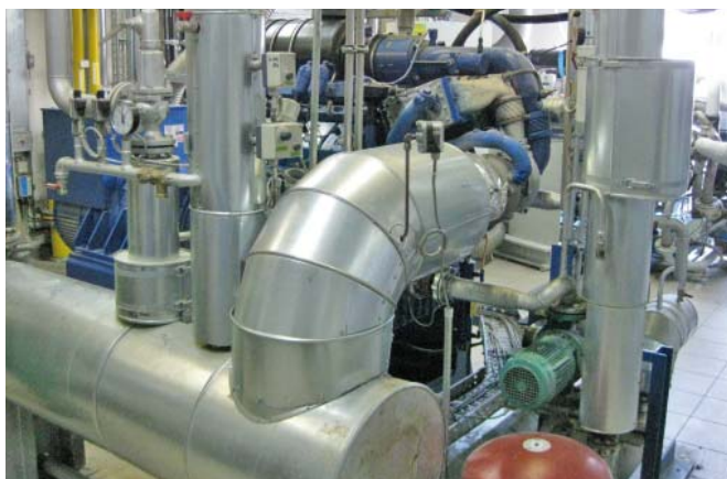
Wärmeleitungen transportieren die Abwärme des BHKW zum Verbraucher
