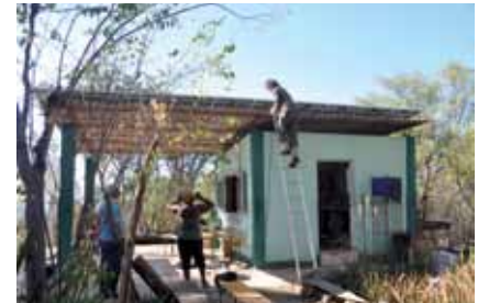
PV Montage auf dem Küchendach
