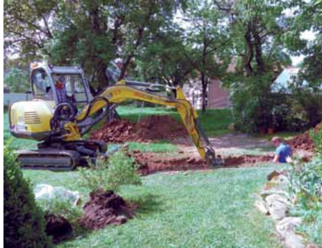
Grabungen für das Nahwärmenetz in Rockenbach
