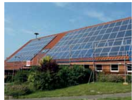
Dorfgemeinschaftshaus Blumenthal – 29,9 kWp – 24.000 kWh Strom im Jahr
