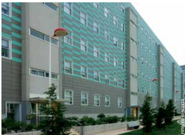
Wohnsiedlung in Zaragoza
