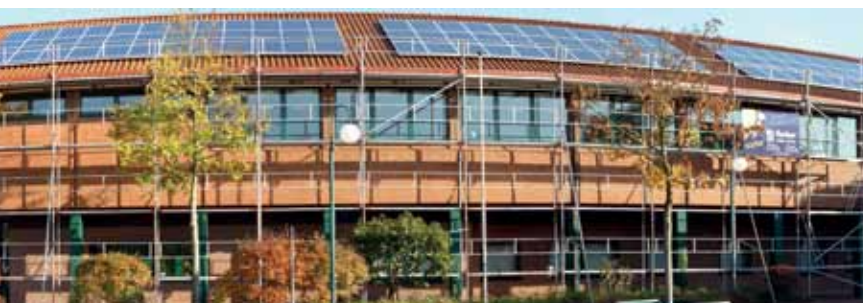
Schulzentrum Oldendorf – 23,6 kWp – 20.000 kWh Sonnenstrom im Jahr
