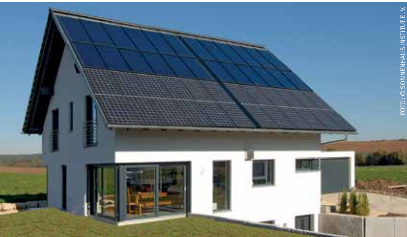
Strom und Wärme kommen beim Sonnenhaus vom Dach – mit PV und Solarthermie
