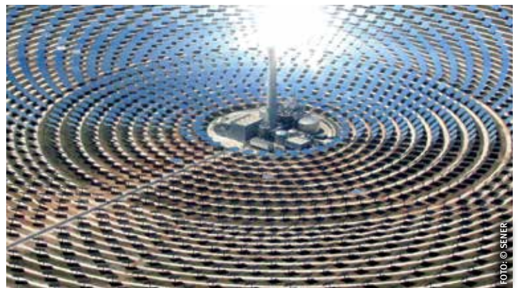
Im Projekt Supergrid forscht das Fraunhofer ISE an der Optimierung und Integration von thermischen Speichern, um die Flexibilität und Effizienz von solarthermischen Kraftwerken zu steigern: Solarthermisches Turmkraftwerk Gemasolar von Torresol Energy in Spanien
