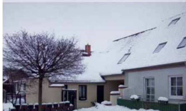
Thermographie eines Einfamilienhauses. Rote Flächen zeigen hohe Wärmeverluste, hier würde sich eine Fassadendämmung lohnen
