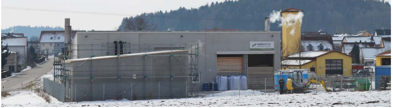
Heizhauserweiterung: Der Rohbau steht
