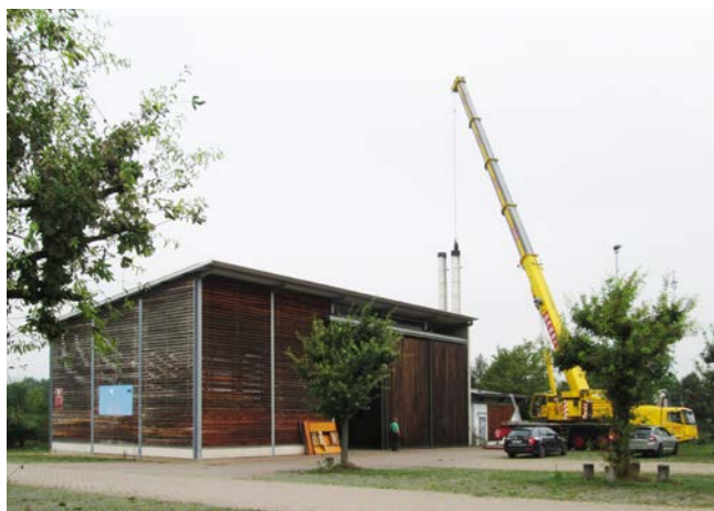
◀ Vor dem Heizhaus in Forchheim sind die Umbauarbeiten in vollem Gange
