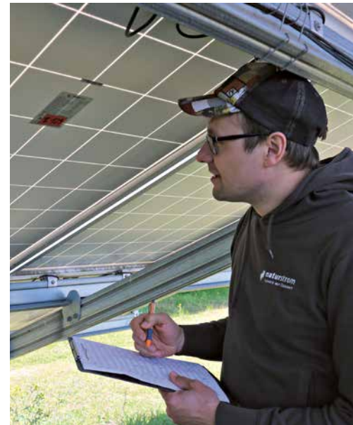
Sebastian Hartmann markiert defekte Module auf der Rückseite
